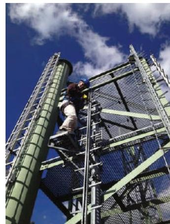
Struttura generale di un'installazione faba™, ogni installazione deve essere eseguita con un minimo di 4 supporti
