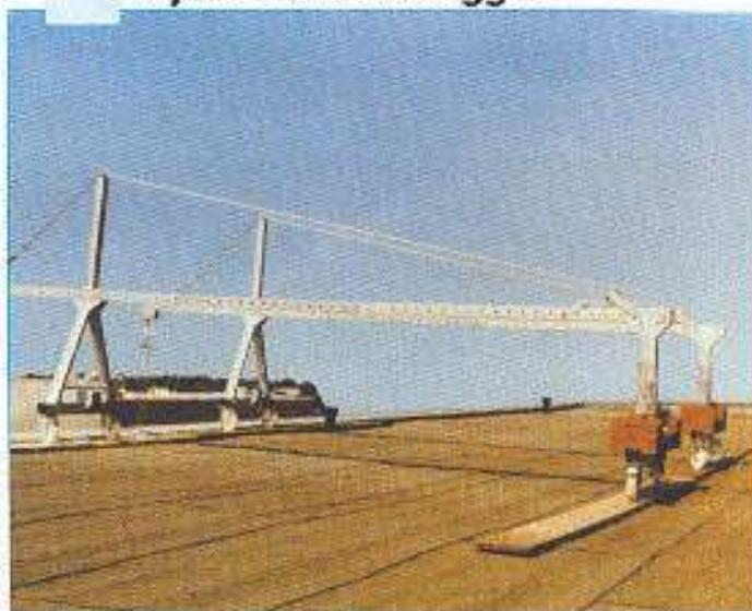
Il punto di ancoraggio generalmente viene realizzato con l'utilizzo di travi di sospensione mobili (travi Portafix). Questa soluzione è molto versatile e consente di approntare un punto di sospensione in breve tempo. Le travi sono completamente smontabili. Il pezzo più lungo misura 2.1m, il pezzo più pesante pesa 25kg. Una coppia di travi viene montata, in copertura, da un paio di montatori (anche non particolarmente esperti) in meno di un'ora.
