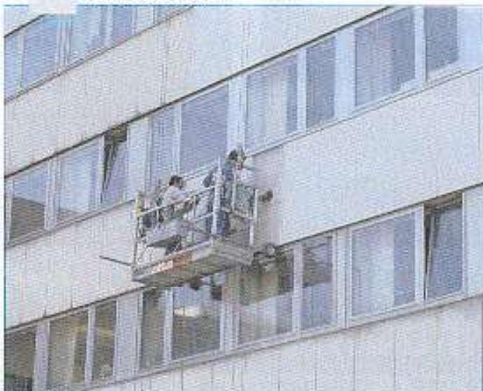
La navicella ospita i lavoratori ed il carico di materiale necessario. La partenza si effettua da terra (partenze dalla copertura sono possibili con l'ausilio di attrezzature particolari) quindi in una condizione comoda, pratica e sicura.
